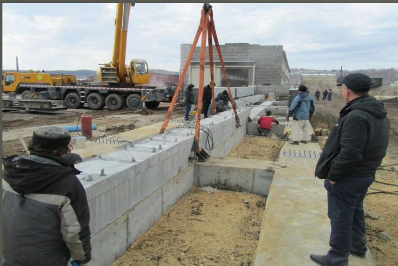
Подготовка к бетонированию (г. Екатеринбург)
