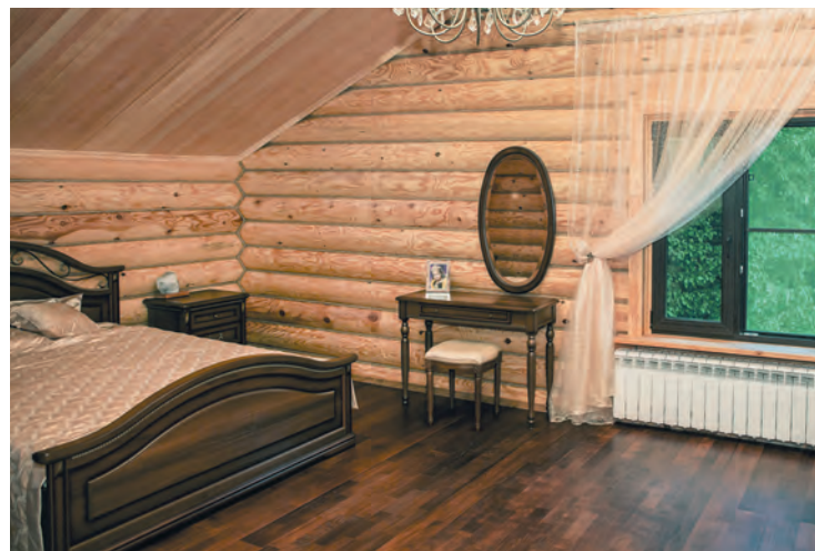
Пол в спальне загородного дома, посёлок Мишнево, Московская область. Материал - массивная доска дуба. Окрашен: 1-й слой 8500 Морилка на основе масла и воска, Цвет: 8546 Венге. 2-й слой 9032 Масло для деревянного пола, Цвет: Бесцветный. 3-й слой 9032 Масло для деревянного пола, Цвет: Бесцветный.
