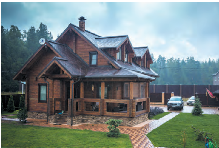
Загородный дом, поселок Здехово, Московская область. Материал - клееный брус, сосна. Окрашен: 1-й слой 8750 Специальный грунт-антисептик. 2-й слой 2043 Масло для наружных работ, цвет: Темный орех. 3-й слой 2043 Масло для наружных работ, цвет: Темный орех.
