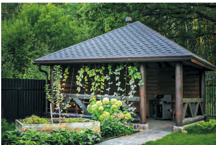
Беседка, поселок Татариново, Московская область. Материал - оцилиндрованное бревно, сосна. Окрашен: 1-й слой 8750 Специальный грунт-антисептик. 2-й слой 1075 Лазурь для дерева, цвет: Голдаخور. 3-й слой 1075 Лазурь для дерева, цвет: Голдаخور. 4-й слой 2043 Масло для наружных работ, цвет: Бесцветный.
