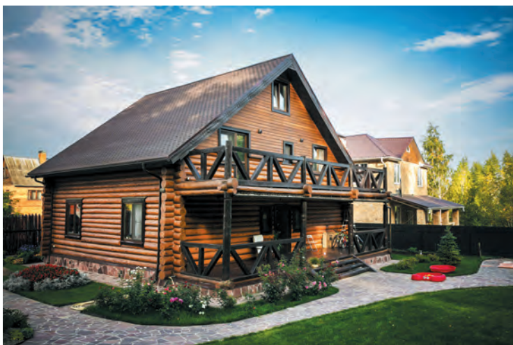
Загородный дом, поселок Татариново, Московская область. Материал - оцилиндрованное бревно, сосна. Окрашен: 1-й слой 8750 Специальный грунт-антисептик. 2-й слой 2043 Масло для наружных работ, цвет: Золотистый тик. 3-й слой 2043 Масло для наружных работ, цвет: Золотистый тик.
