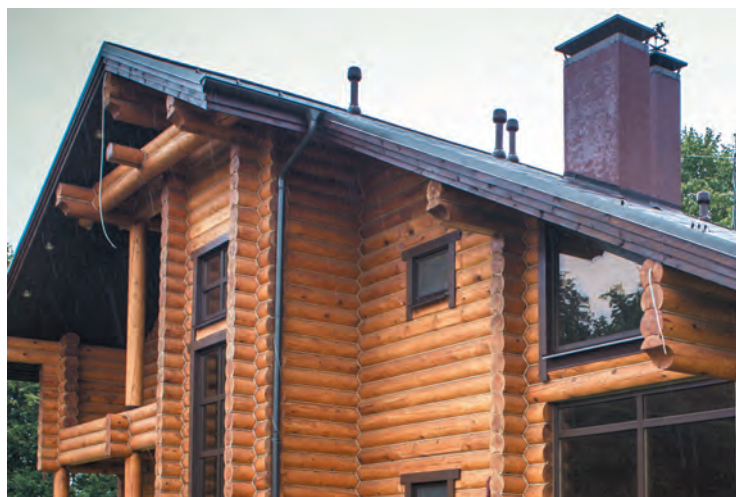
Загородный дом, поселок Мишнево, Московская область. Материал - оцилиндрованное бревно, сосна. Окрашен: 1-й слой 8750 Специальный грунт-антисептик. 2-й слой 1075 Лазурь для дерева, цвет: Золотистый тик. 3-й слой 1075 Лазурь для дерева, цвет: Золотистый тик. 4-й слой 2043 Масло для наружных работ, цвет: Бесцветный.
