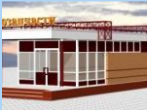
Торговый центр «Автозапчасти», г. Нижний Новгород
