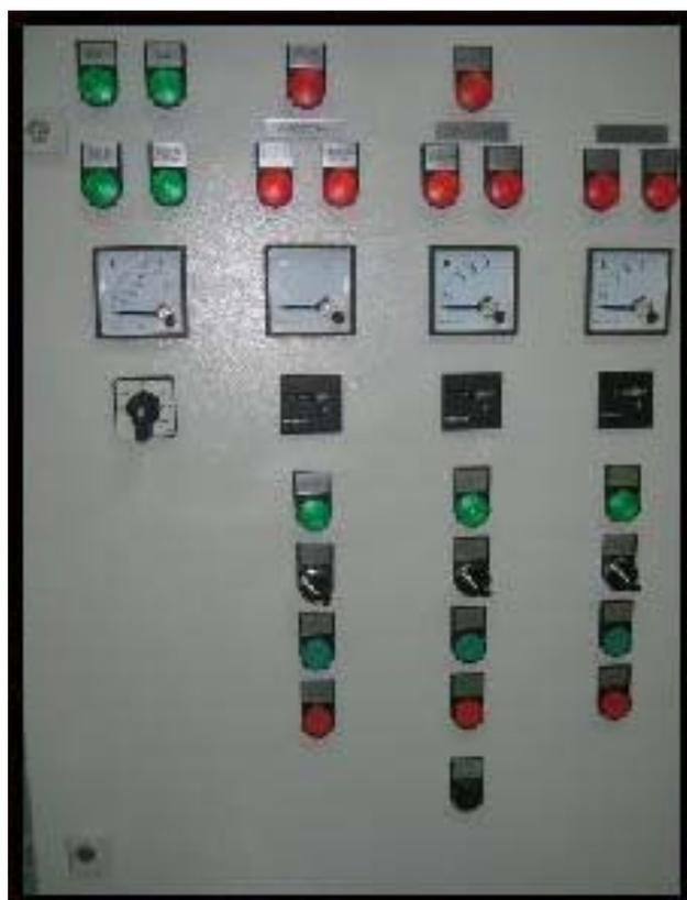
Насосы при этом не останавливаются. После понижения уровня до срабатывания поплавка общего отключения насосов, индикатор погасает, сигнальные контакты размыкаются. В качестве аварийного сигнализатора может использоваться сигнальное устройство типа сирена или проблесковый маячок, а также их комбинация.
