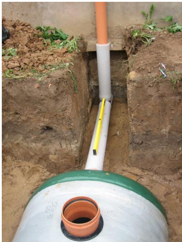
Прокладка и утепление подводящего трубопровода. Установка фанового стояка.
