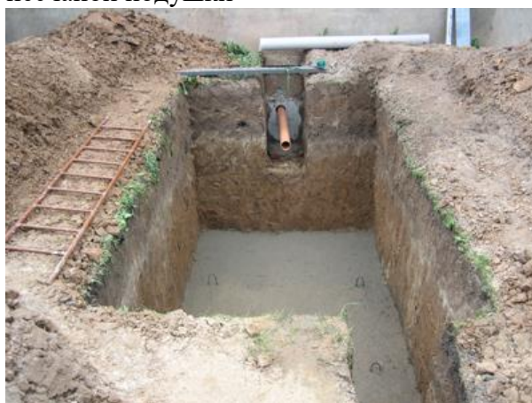
Монтаж ж/б плиты основания емкости
