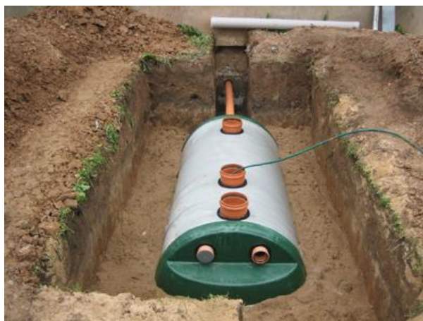
Обратная засыпка септика FloTenk и заполнение его водой
