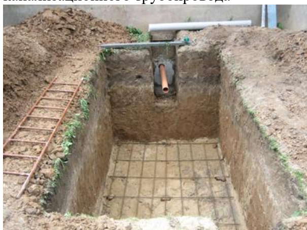
Вязка арматуры для заливки плиты основания септика
