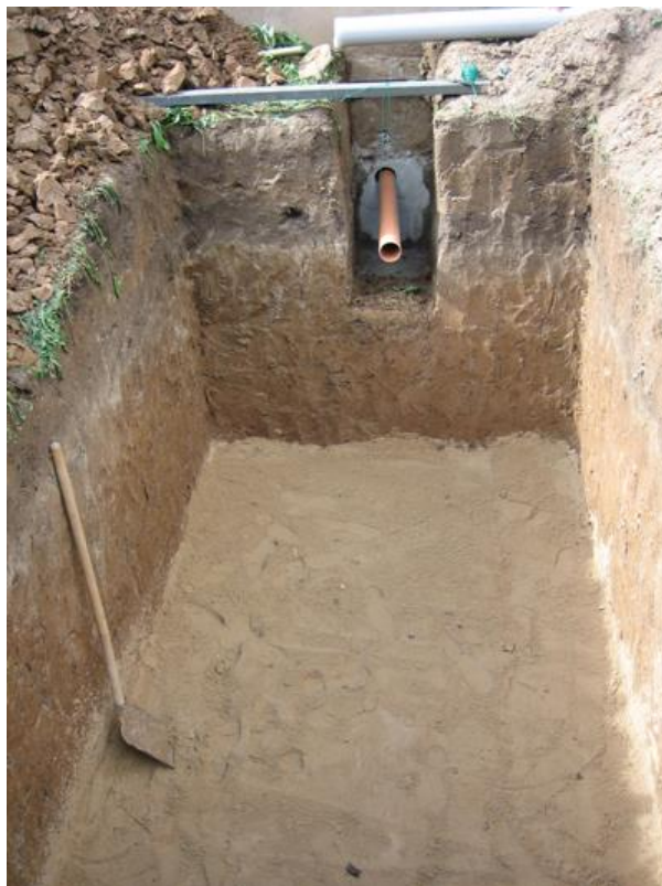
Выемка грунта в отвал вручную, устройство песчаной подушки
