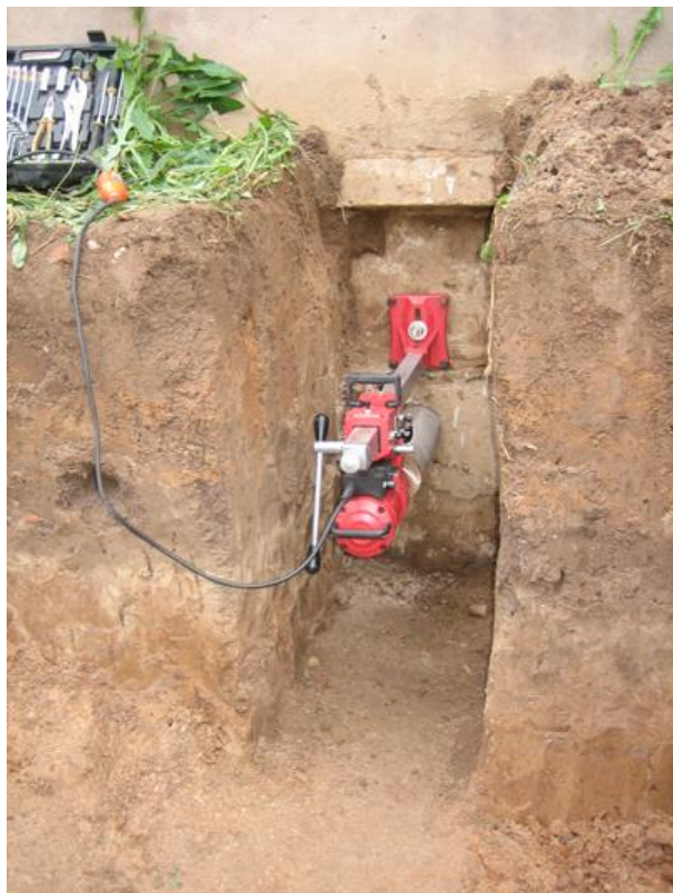
Алмазное сверление фундамента для прокладки канализационного трубопровода
