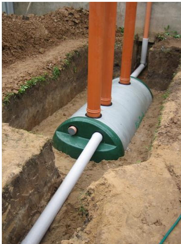
Монтаж удлинительных горловин. Прокладка и утепление отводящего трубопровода.
