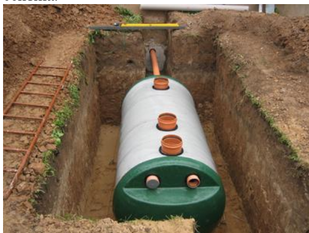
Установка септика в котлован. Привязка емкости нержавеющей тросом к анкерным кольцам.
