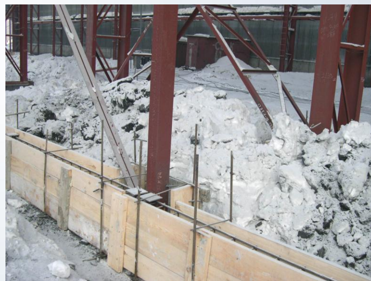
г. Новосибирск. Январь, 2008 г. Температура – 20 град.С. Ленточные фундаменты под навесные панели.
