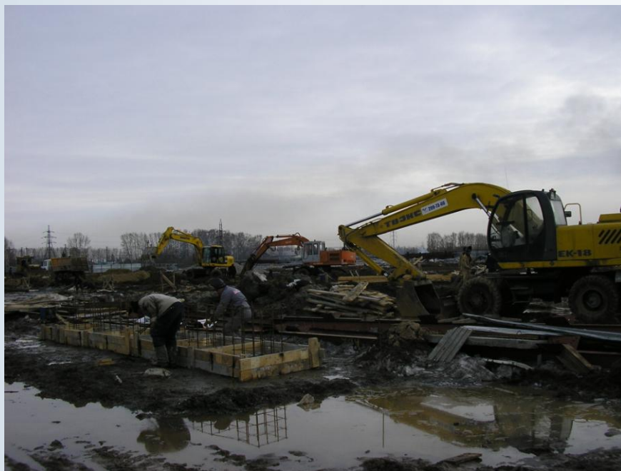
Устройство фундаментов в условиях обводнения грунтов (г. Новосибирск, ул. Тайгинская – столбчатые фундаменты)
