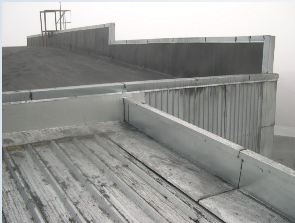
Монтаж кровли и покрытий
