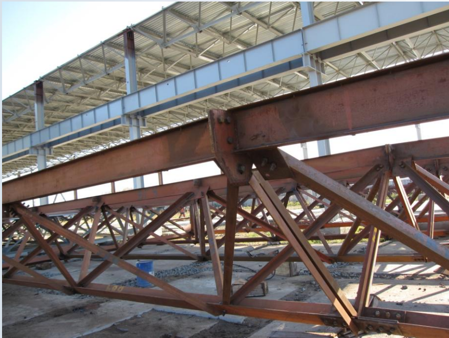
Сборка структур на земле на укрупнительных стендах
