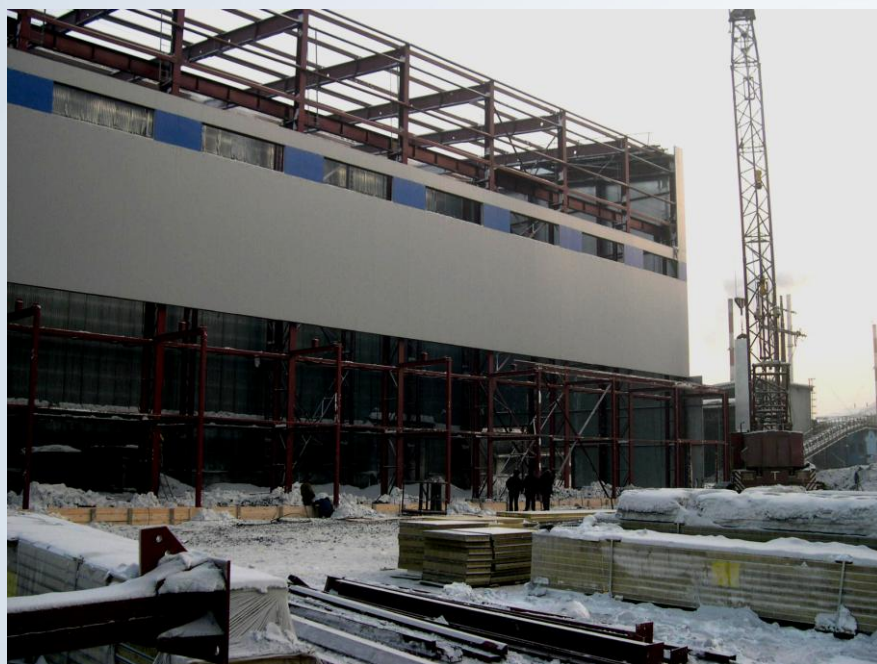
Монтаж стеновых панелей.
