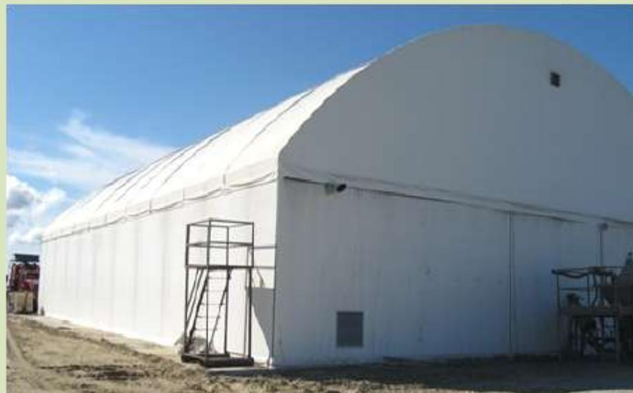
Обширное внутреннее пространство и высокие потолки каркасно-тентовых конструкций позволяют свободно перемещать оборудование. Кроме того, естественное освещение позволяет работать в течение дня без использования электрических ламп, тем самым, сокращая расходы на электроэнергию
